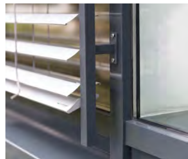
Führungsschiene mit Abstandhalter
